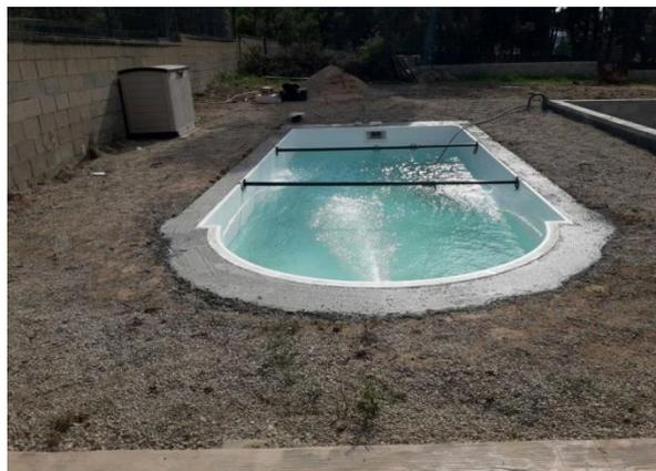
Avant de mettre le béton, une tige de fer de 5 mm devra être placée. Une fois que la poutre en béton aura été fabriqué, nous procéderons à l'enlèvement des jambes de force.
