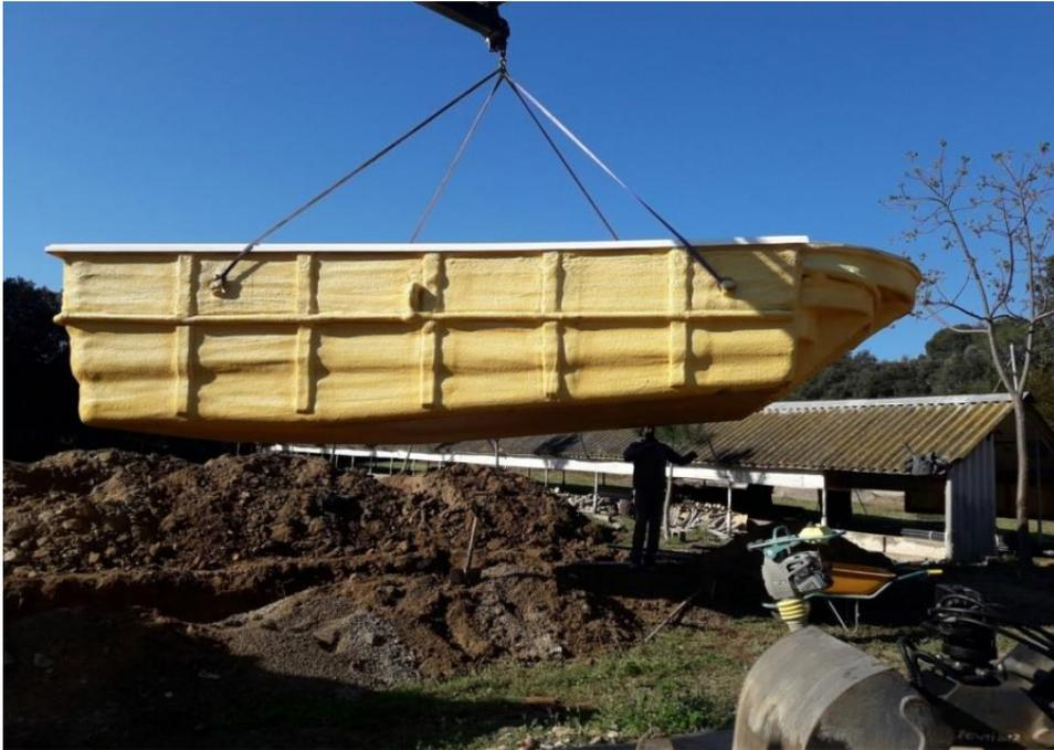
**7- UNE FOIS LA PISCINE PLACÉE À L'INTÉRIEUR DU TROU D'EXCAVATION, NOUS EFFECTUERONS LE NIVELLEMENT DES 4 ANGLES INTÉRIEURS DE LA PISCINE, EN TENANT COMPTE DE LA COTE 0.**
