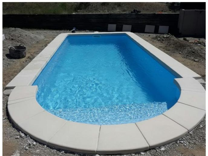
Avant de placer la margelle, il est nécessaire de mettre les rehausseurs de skimmer de sorte que le couvercle soit à la hauteur de la margelle.
