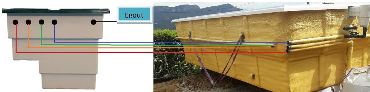
**Les raccordements aux tuyaux doivent être effectués à travers le fossé (POINT 2)**
